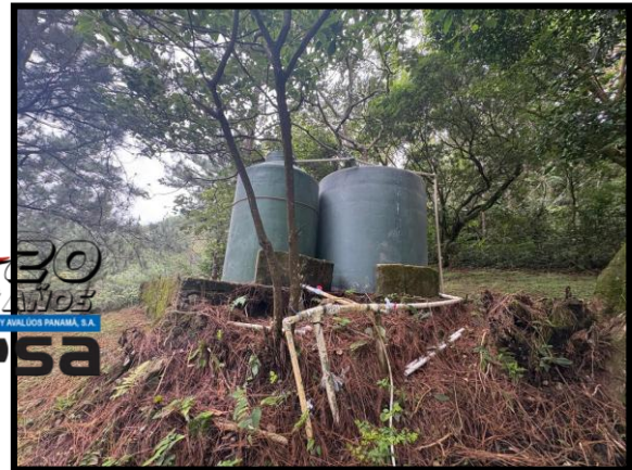
VISTA GENERAL DEL TANQUE DE RESERVA
