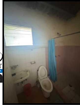
VISTA GENERAL DEL SERVICIO SANITARIO
