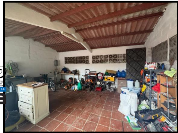
VISTA DEL DEPOSITO
