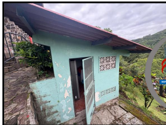
VISTA DE LA LAVANDERÍA
