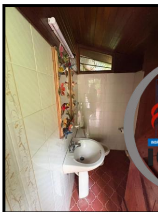
VISTA GENERAL DEL MEDIO SERVICIO SANITARIO
